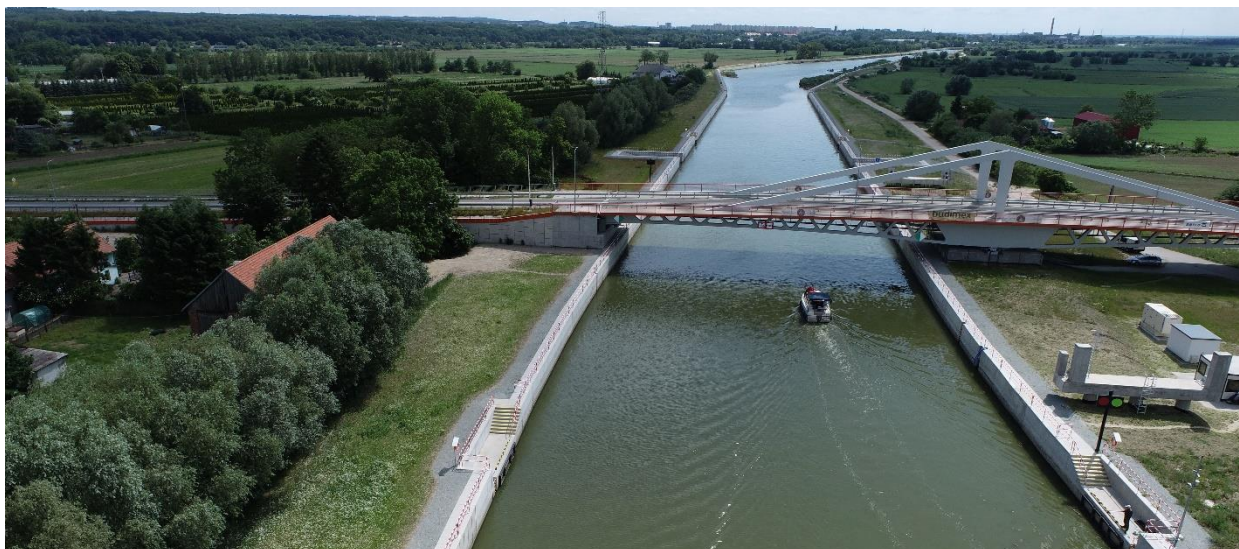
Podejście do Elbląga – Nowakowo. Most Obrotowy
