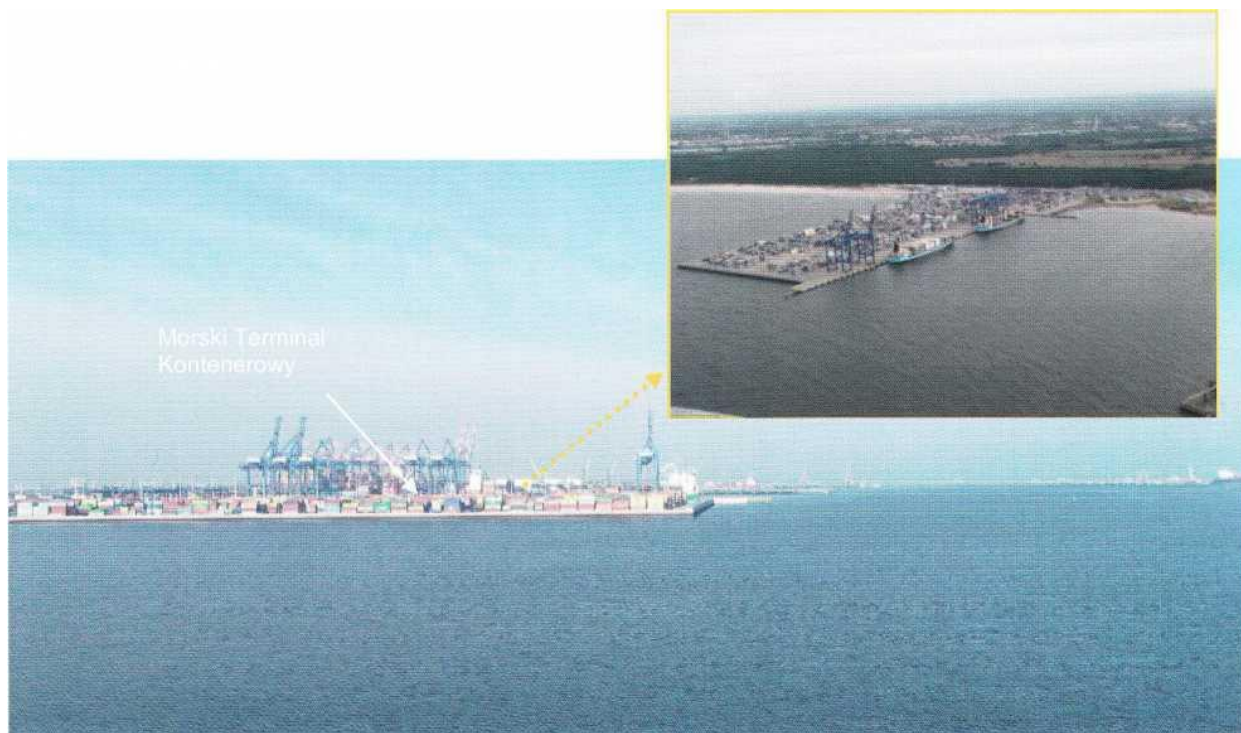
Port Północny – na wschód od wejścia głównego
