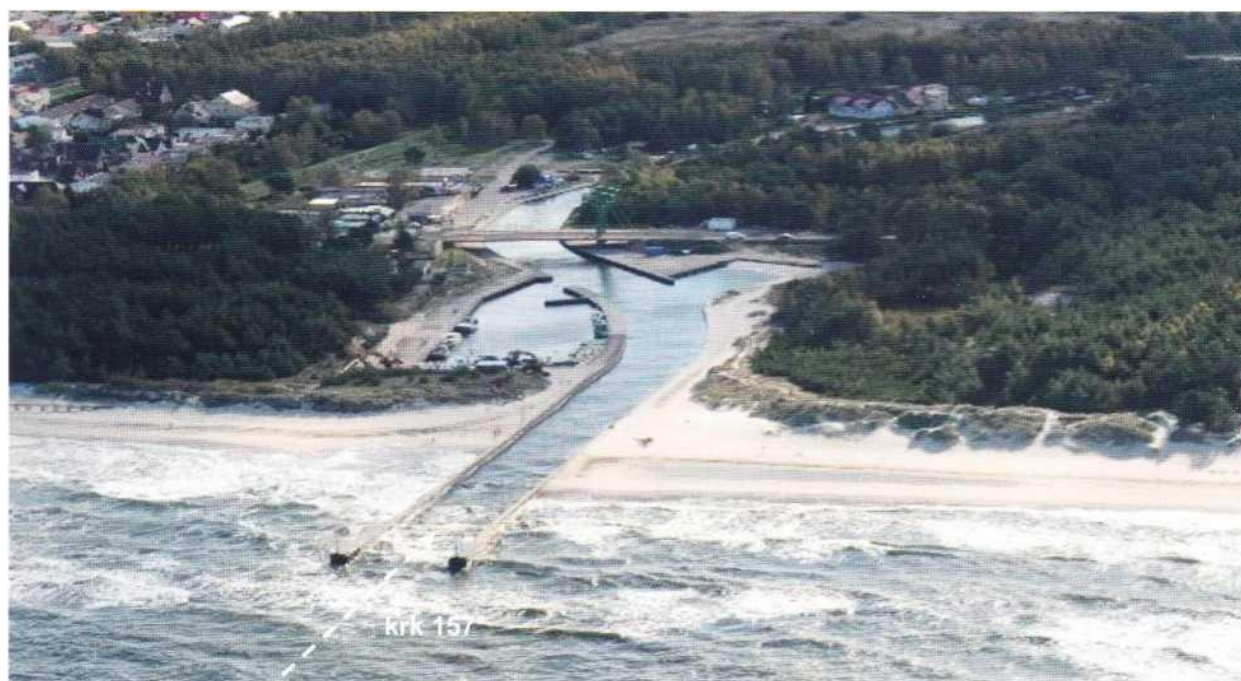
Dźwirzyno – wejście do portu
